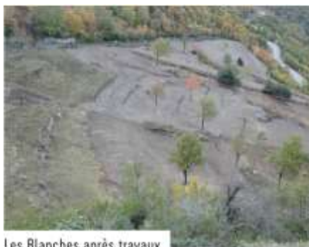
Les Blanches après travaux
